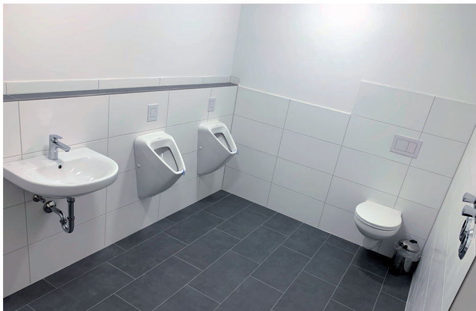
Im Sanitärbereich fehlen nur noch die Trennwände für die Privatsphäre...
